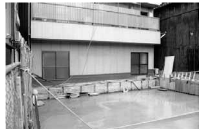
拡張場所の基礎工事中
