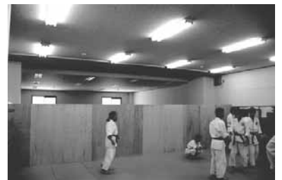
旧外壁が取り払われたあとはこのように仕切られて工が進められました。
